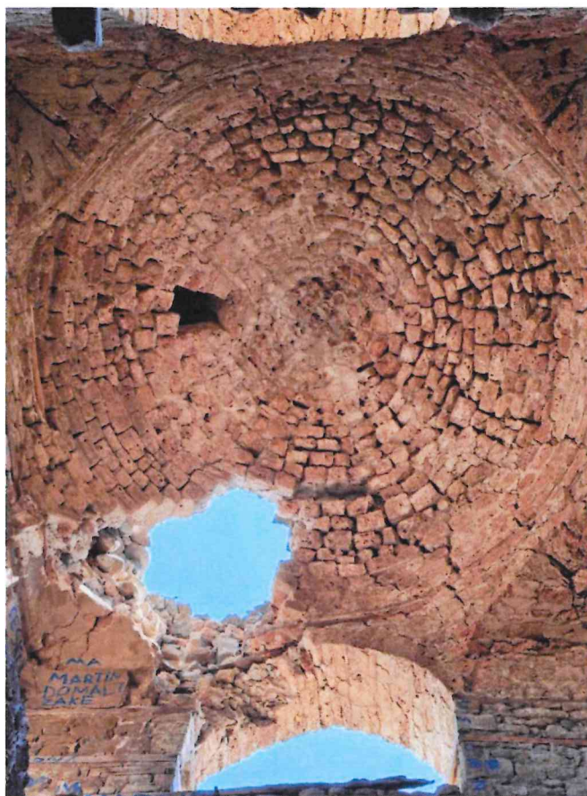
Mungese e llacit lidhes dhe fugatimit ne kupole, FOTO 2025
