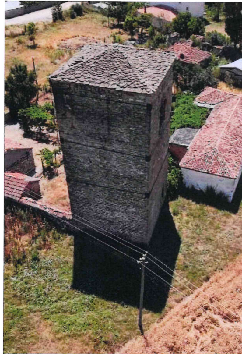
FOTO TE GJENDJES EKZISTUESE
