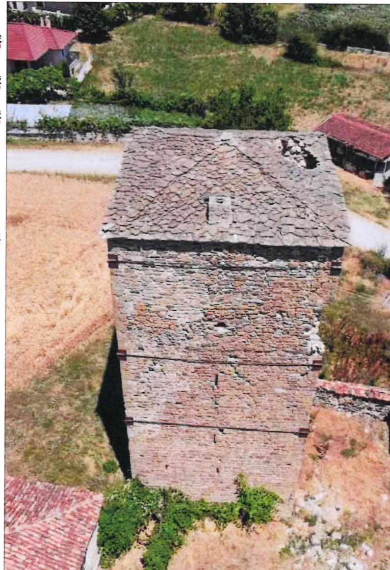
FOTO TE GJENDJES EKZISTUESE
