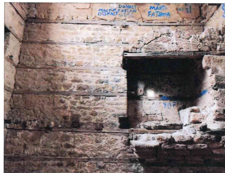
FOTO TE GJENDJES EKZISTUESE
