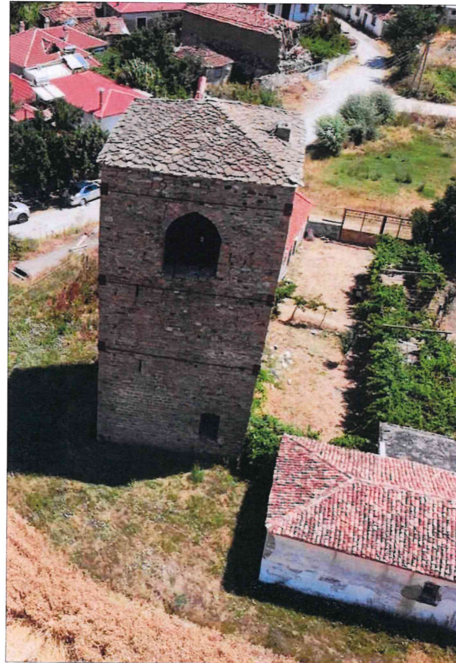
FOTO TE GJENDJES EKZISTUESE
