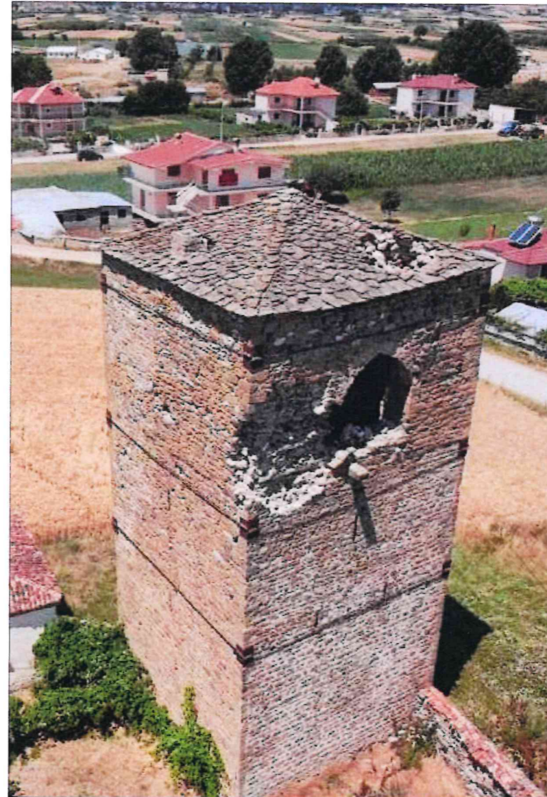
FOTO TE GJENDJES EKZISTUESE
