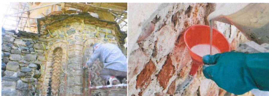
Shëmbull i procesit të konsolidimit të muraturës
