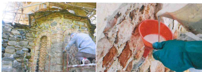
Foto 10. Shembull i procesit të konsolidimit të muraturës
