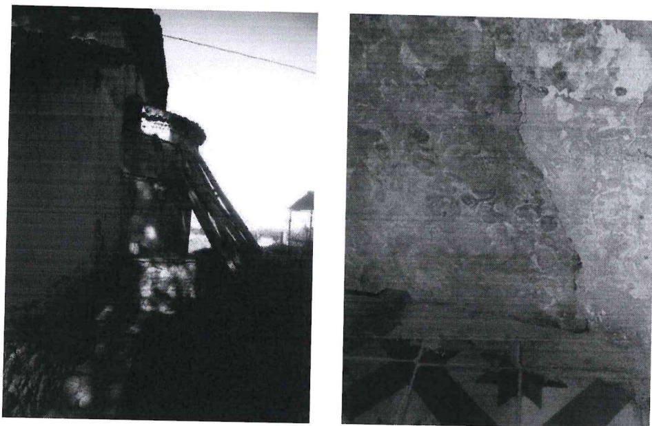
Fig. 13. Inklinim i murit të absidës dhe çarje në murin e brendshëm
