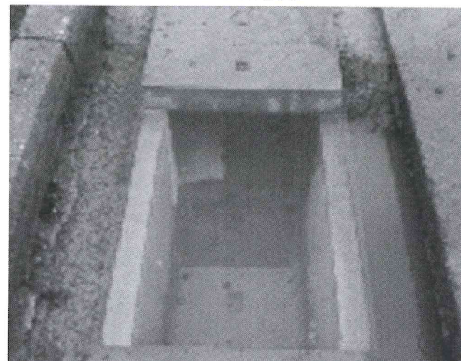
PAMJE E KANALINAVE PREJ BETONI
