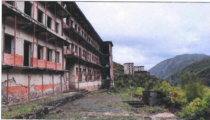
Foto te gjendjes ekzistuese
