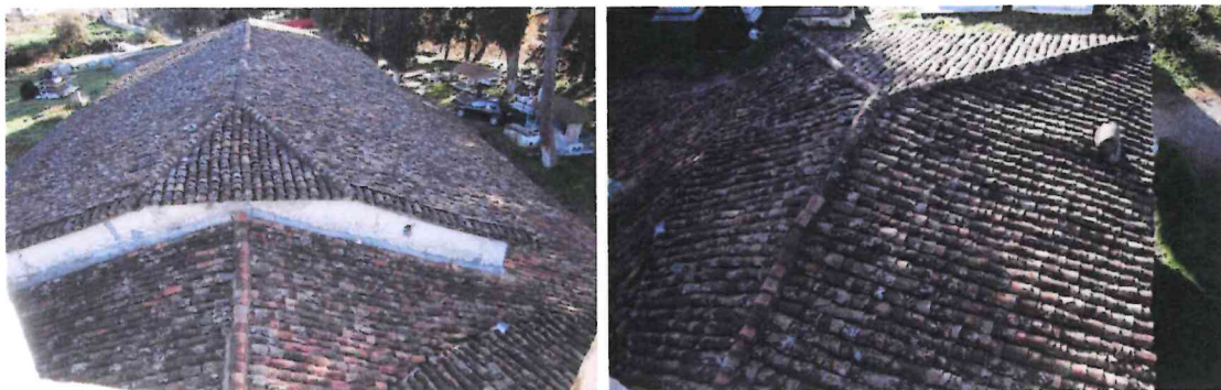
Fig 3. Pamje e çatisë dhe pamje e fasadës veriore
