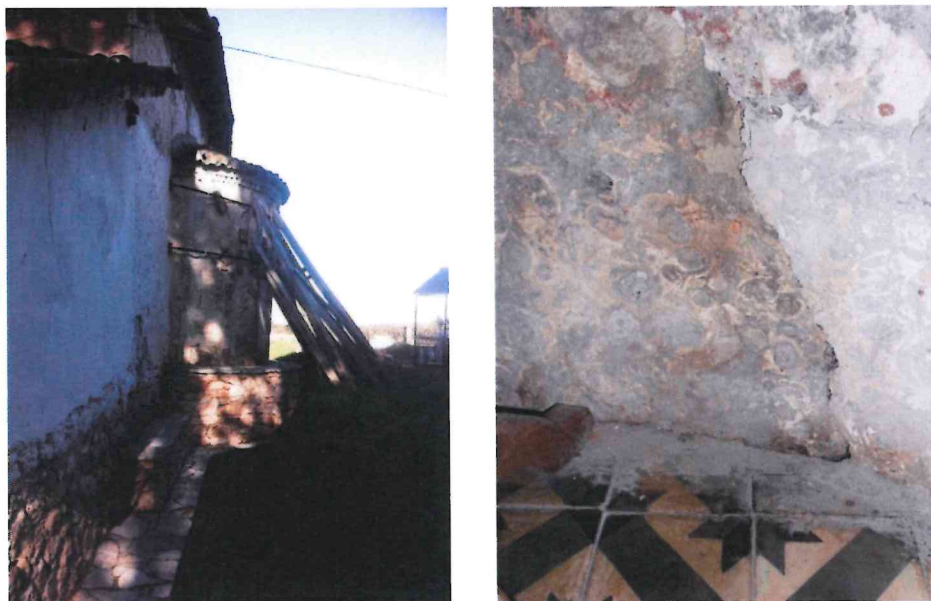
Fig. 13. Inklinim i murit të absidës dhe çarje në murin e brendshëm
