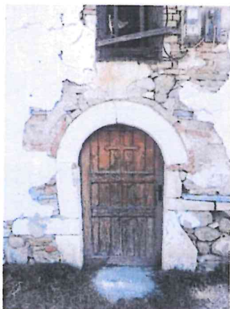
Portë në fasadën perëndimore
