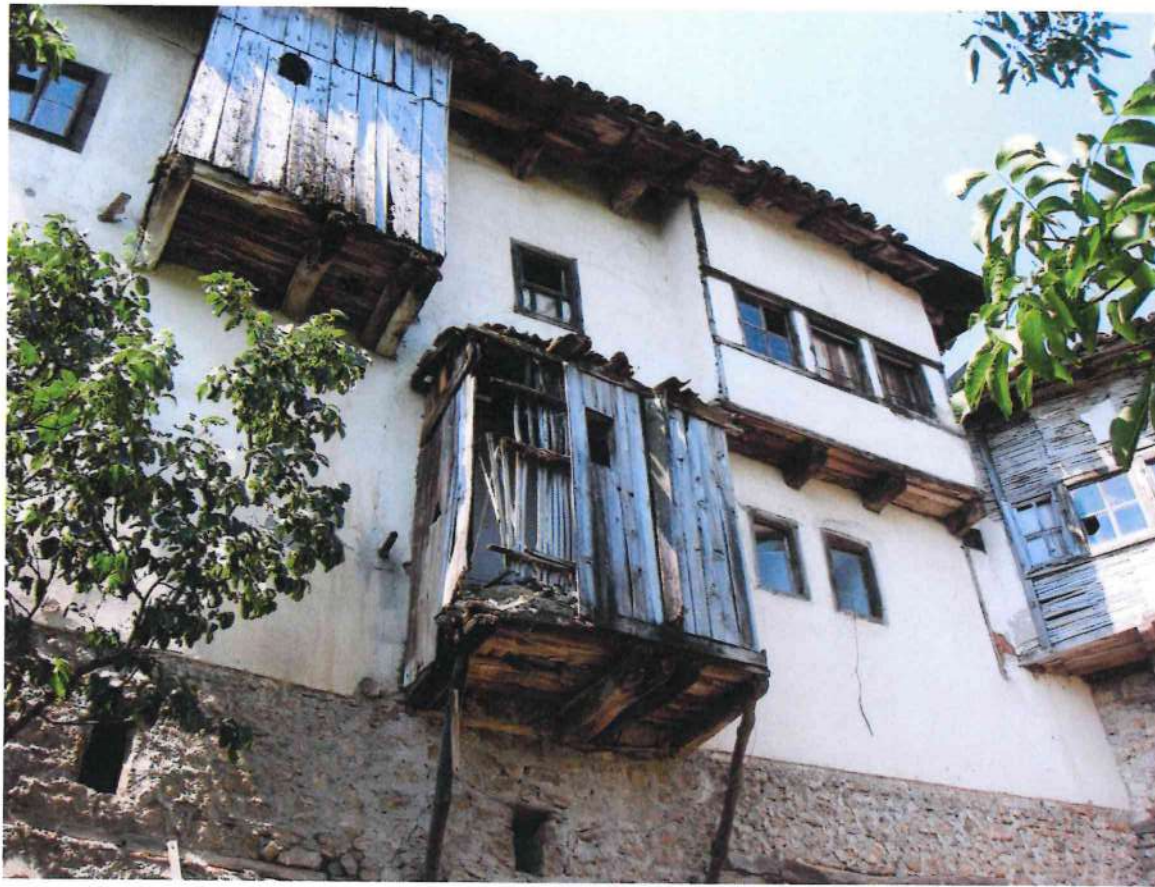
Figura 5. Daljet konsol, banesa e Mustafa Shehut, Zërqa
