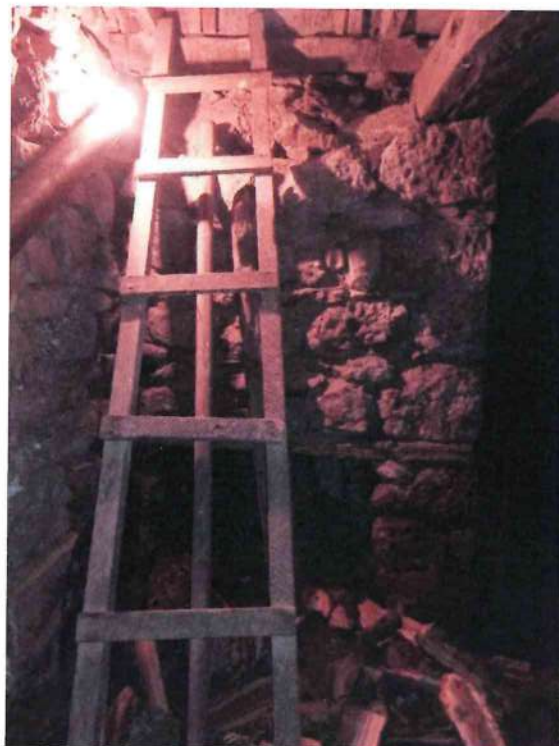
Figura 34. Kati përdhe, bërthama 2- shkallët ekzistuese posht baxhës
