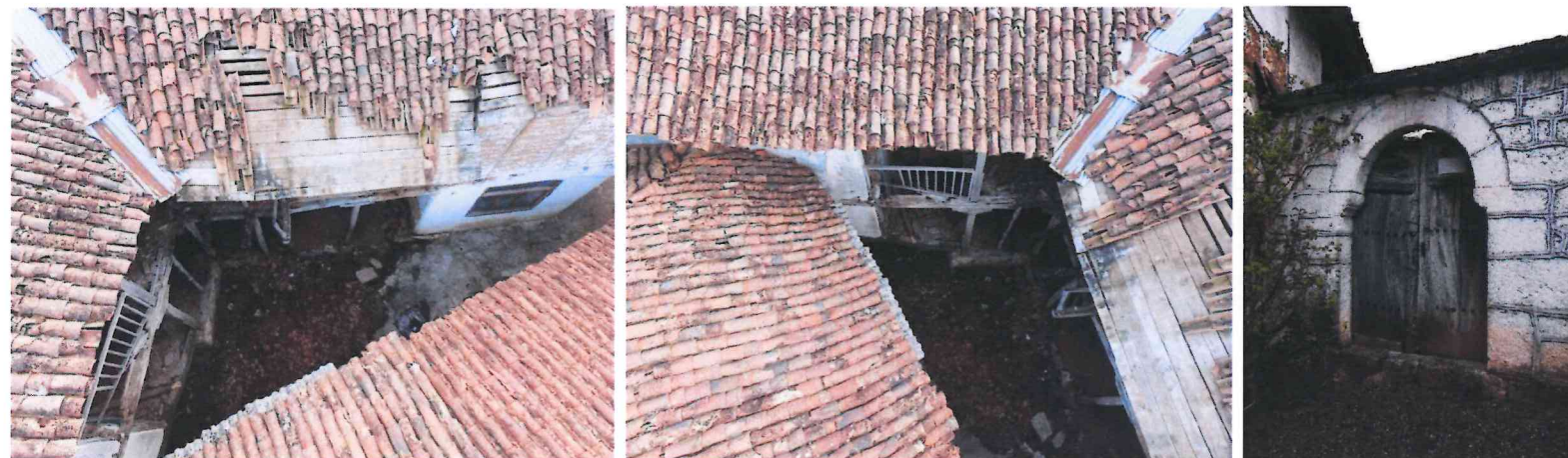
FOTO TE GJENDJES EKZISTUESE
