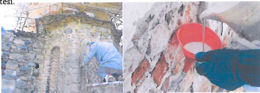
Foto 19. Shëmbull i procesit të konsolidimit të muraturës
