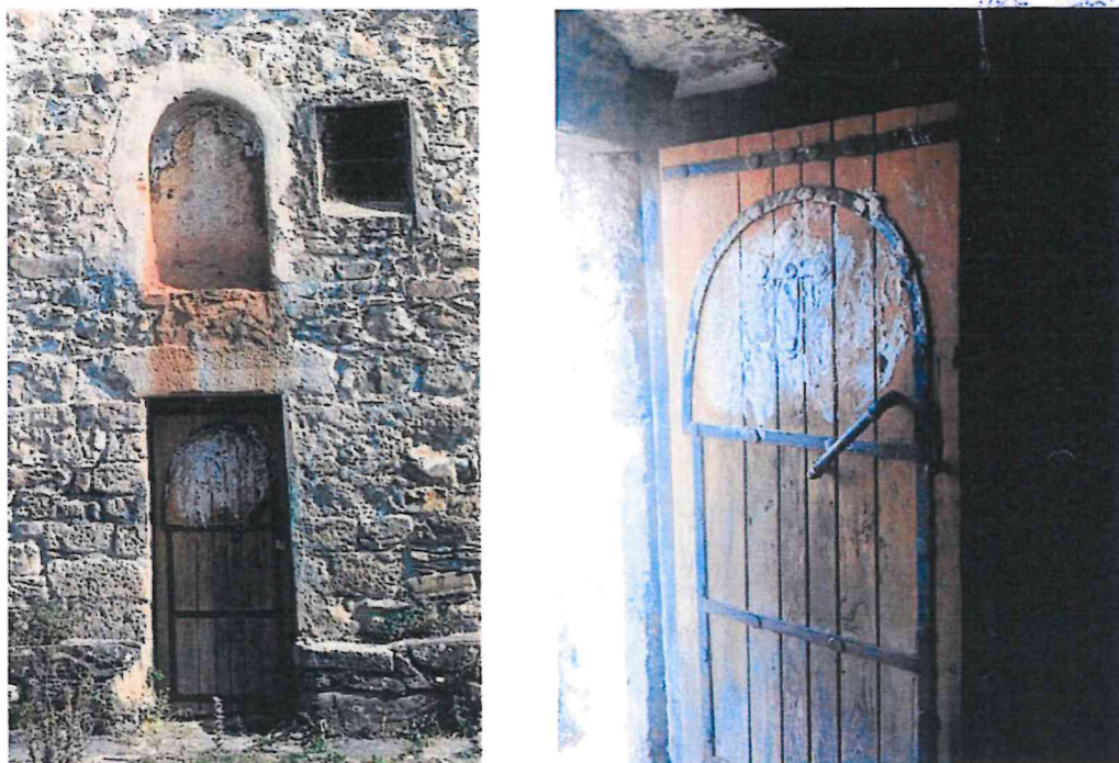
Figura 5 Porta hyrëse në fasadën perëndimore
