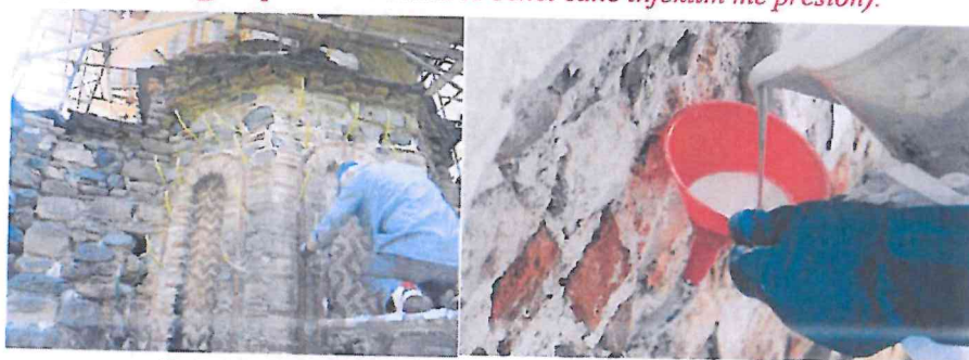
Foto 19. Shëmbull i procesit të konsolidimit të muraturës
