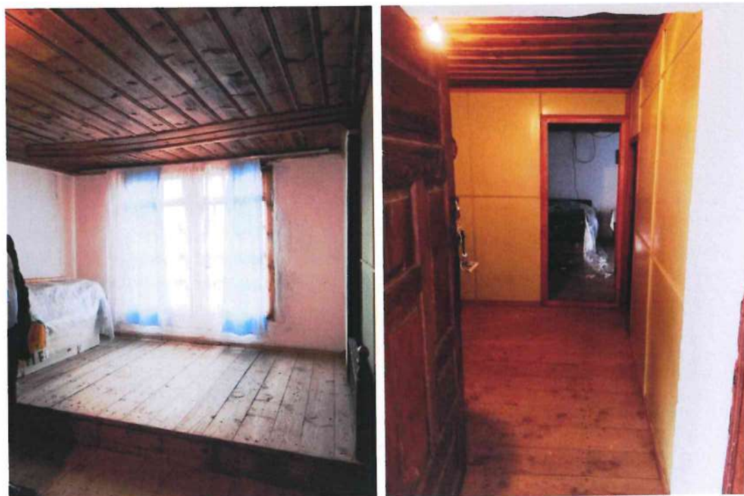
Figura 53. Ambient 4, majtas- pamje e qoshkut, djathtas- ndarja e mbjentit me fibër realizuar në 1980.
