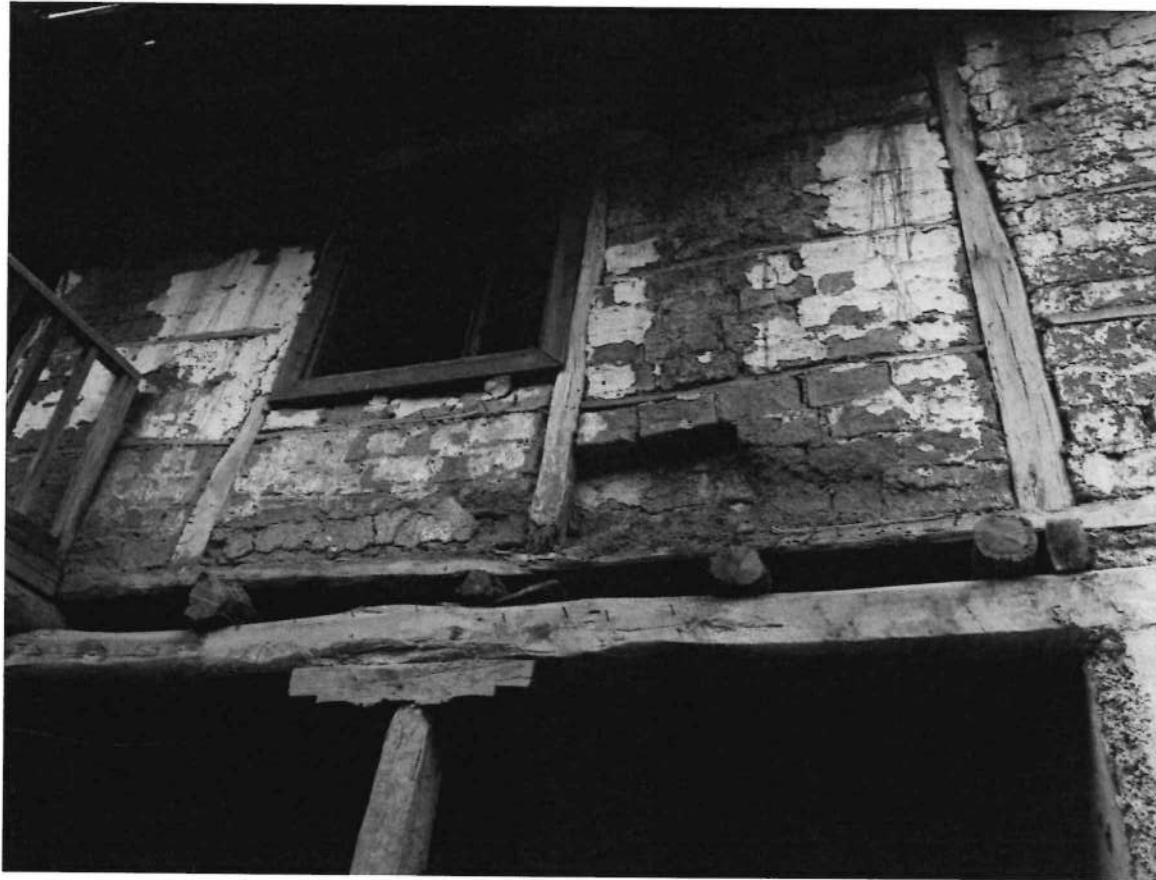
Figura 3. Mur me qerpiç dhe breza druri, banesa e Mustafa Shehut, Zerqan
