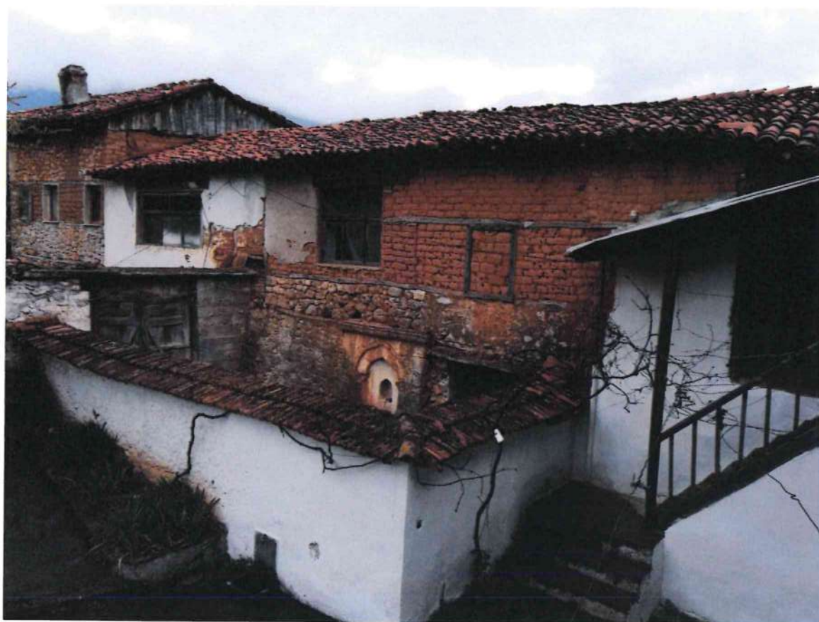
Figura 4. Ndërthurja e murit të gurit me ate të baltës, banesa e Mustafa Shehut, Zerqan
