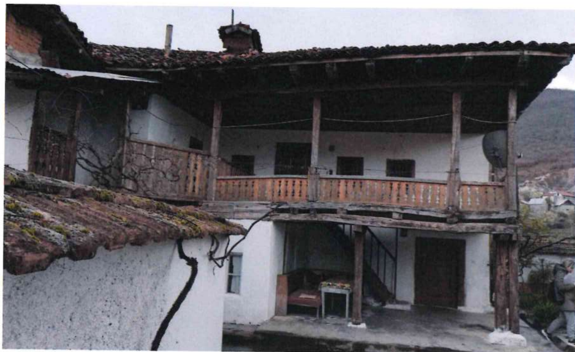
Figura 13. Bërthama e dytë, hajati dhe çardaku i saj, fasada perëndimore
