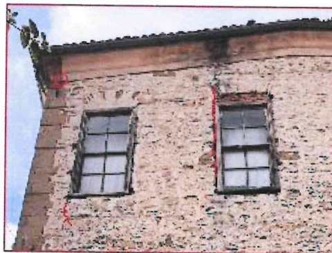
CARËS NË NIVELIN E TAVANIT PËR SHKAK TË VËRRIMIT TË FORCESË SËMË DHE LUNDËS JË TË MËRË
