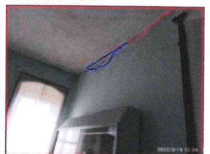
CARËS NË NIVELIN E TAVANIT PËR SHKAK TË VËRRIMIT TË FORCESË SËMË FUTJË LAGESHTISË NGA CATI NË NIVELIN E TAVANIT
