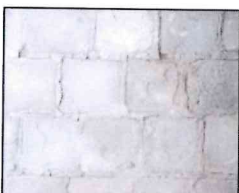
Plasasje te pllakeve te ardhimit dhe degradimi i fudhurit. Te behet zverdesimi i pllakeve te detyruar dhe rimbajtja e fudhurit.
