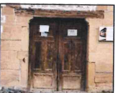
Amortizim i lendes drusore te detyr. Te gjithë elementet e detyr te detyr te zverdesohen. Elementet e tjere te pastohen dhe te trajtohen me vaj (in) dhe ant miale.
