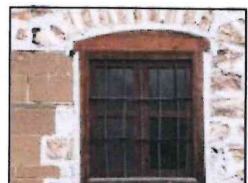
Amortizim i lendes drusore te detyr. Te gjithë elementet e detyr te detyr te zverdesohen. Elementet e tjere te pastohen dhe te trajtohen me vaj (in) dhe ant miale.
