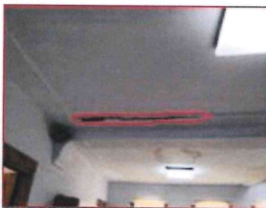
CARËS NË NIVELIN E TAVANIT PËR SHKAK TË VËRRIMIT TË FORCESË SËMË DHE LUNDËS JË TË MËRË
