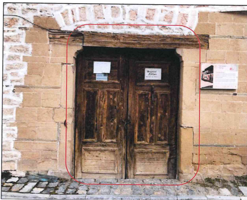
Degradim i drurit, brezave dhe dyerve.
