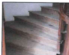
Planim i lendes drusore te shkallave dhe te apertimit. Te gjithë elementet e detyruar te shkallave te zverdesohen dhe te trajtohen me vaj (in) dhe ant miale. Elementet e korrendes te detyruar te trajtohen me vaj (in) dhe ant miale.
