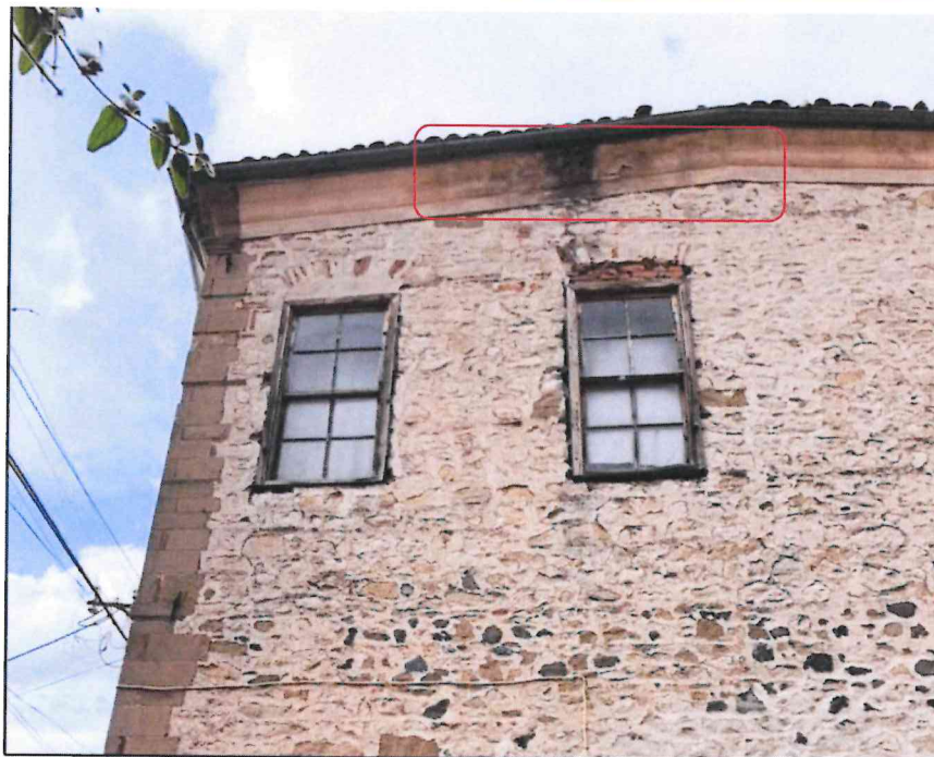
Demtim i kornizes se gipsit , demtim i fugatimit.
