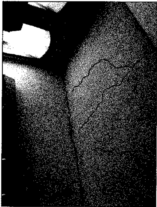
CARJE NE NIVELIN E TAVANIT DHE MURATURES PER SHKAK TE VEPRIMIT TE FORCES SIZMIKE DHE LIDHJES JO TE MIRE MURATURE TAVAN.
