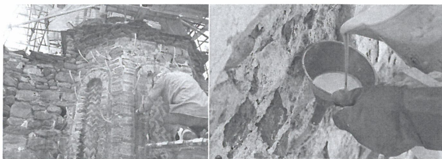
Shëmbull i procesit të konsolidimit të muraturës
