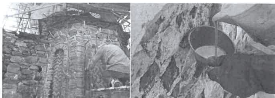
Shëmbull i procesit të konsolidimit të muraturës
