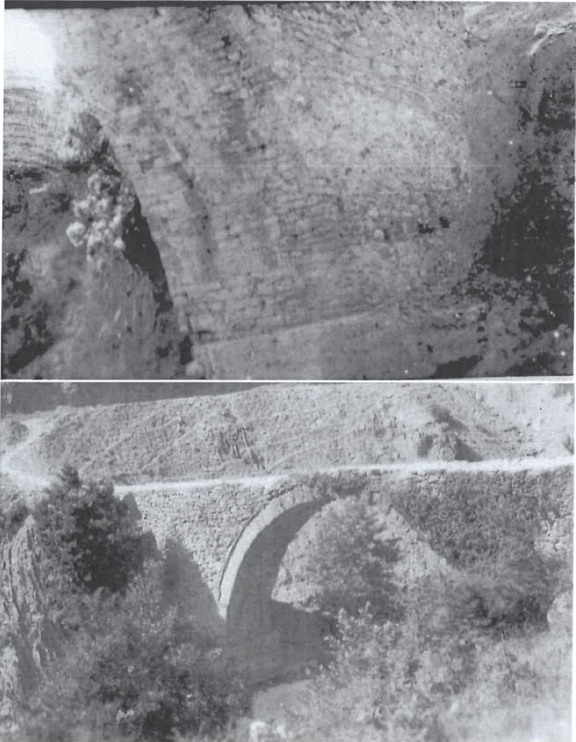
Fig.11- Përforcimi me jastëk betoni këmba e urës në të majtë, lartë-bjefi i sipërm, poshtë bjefi I poshtëm realizuar në viti 1979
