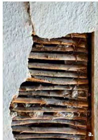
a. Mur i brendshëm tipik me çatma. Pamja nga afër tregon skeletin prej degëve të drurit dhe suvatimin me llaç gëlqereje.
