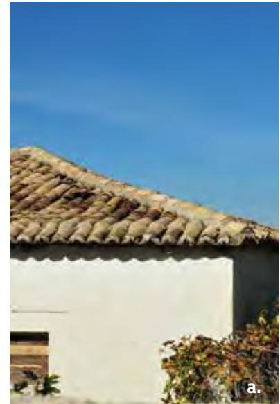
a. Një çati dy-ujëse, karakteristike për këtë rajon. Tjegullat ndryshojnë lehtë në ngjyrë, për shkak të ekspozimit në diell dhe sepse janë të punuara në mënyrë artizanale.
