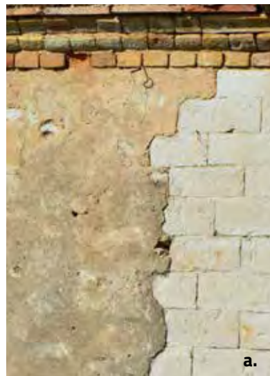
a. Pamja nga afër e një murature dhe e kornizës së murit në Himarë fshat. Lyerja me gëlqere të bardhë në anën e djathtë të murit është teknika e këshilluar për t'u përdorur, ndërsa suvatimi i trashë në anën e majtë nuk rekomandohet.
