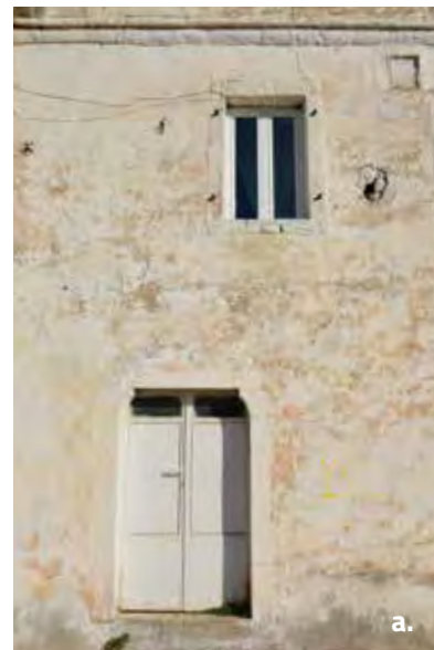
a. Një banesë me dy kate në fshatin Himarë, me dritare dhe dyer plastike, të cilat nuk duhen përdorur në këtë rajon për shkak se shkaktjnë probleme teknike dhe estetike.
