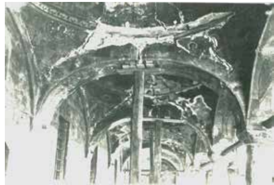
Fig. 11 Kisha e Shën Nikollës, Pas tërmetit 1960 hajati i punteluar Fig. 11 Church of Shën Nikolla, after the 1960 earthquake, shoring hayat
