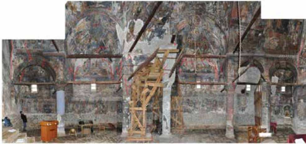
Fig. 67 Analiza e degradimeve në faqen e brendshme të muraturës veriore (prezantimi i Grupit 4)
