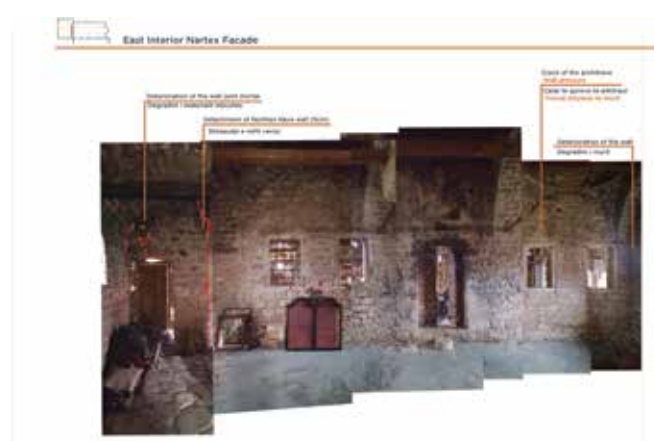
Fig. 70 Analiza e degradimeve të muraturës perëndimore, pamje nga narteksti (prezantimi i Grupit 2)
