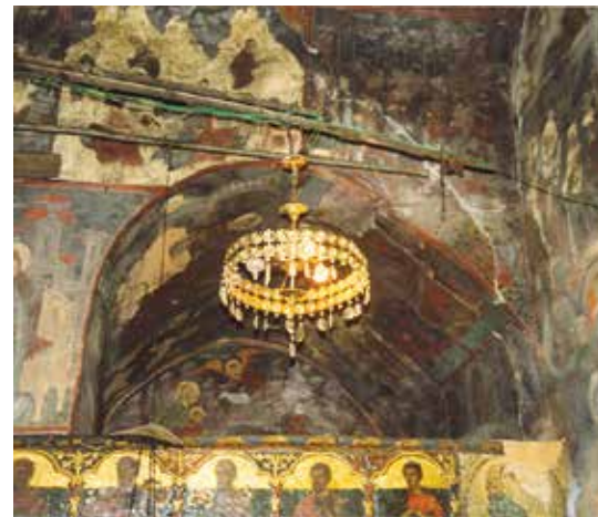
Fig. 20 Kisha "Fjetja e Shën Marisë" në Zervat të Gjirakastrës – Forma të çrregullta të harqeve dhe qemereve Fig. 20 Church of "Fjetja e Shën Marisë" in Gjirakastra Zervat – Irregular shapes of arches and vaults
