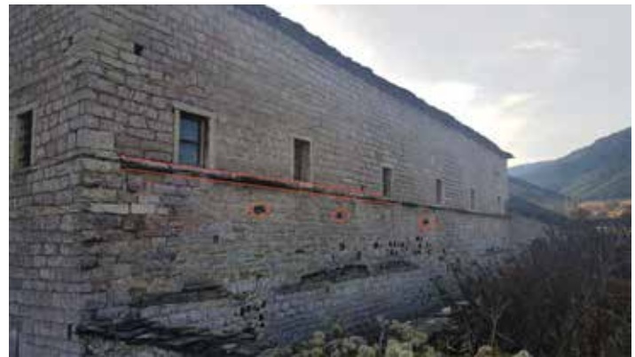
Fig. 59 Muri verior i naosit, ku janë të dukshme gjurmët e lidhjes së tij me hajatin verior (përgatitur nga Grupi 2)
