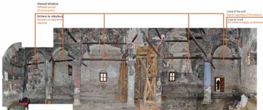
Fig. 68 Analiza e degradimeve në faqen e brendshme të muraturës jugore (prezantimi i Grupit 2)
