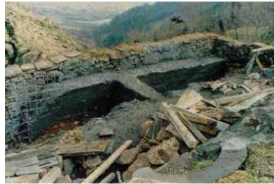
Fig. 46 Kisha e Shën Mërisë, Leusë, foto gjatë punimeve të konsolidimit të terrenit për stabilizim rrëshkitje Fig. 46 Church of Shën Maria, Leusë, picture during the terrain consolidation for sliding stability
