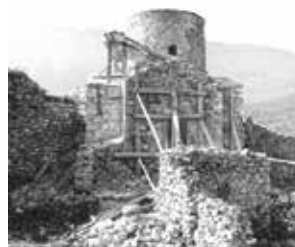
Fig. 36 Kisha e Marmiroit, foto e gjendjes së monumentit gjatë ndërhyrjeve plotësuese
