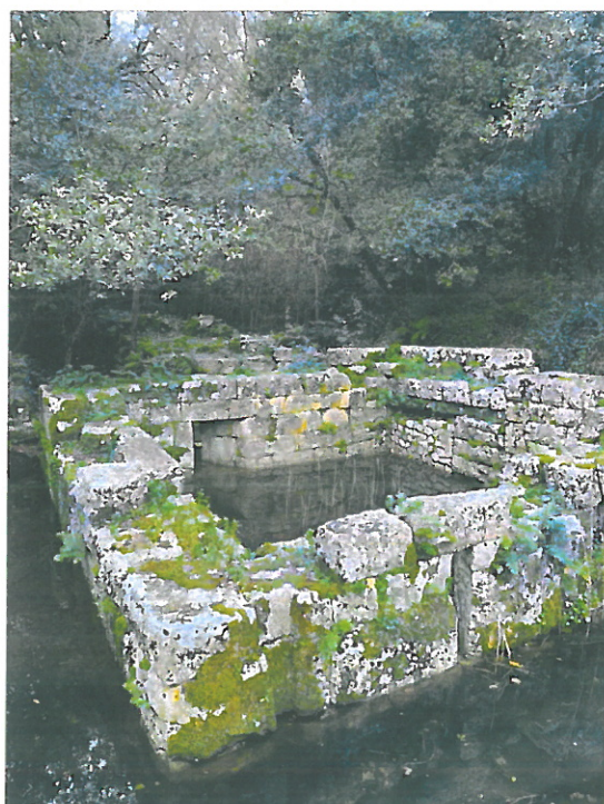
6. Foto e kullës katrore (nga veri-perëndimi). Vihet re mbushja e muraturës me teknikën e opus reticulatum si dhe ndërhyrja me vendosjen e arkitraut me beton mbi të.
