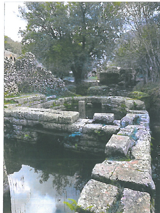
2. Foto e të kullës në formë patkoi (nga jugu). Niveli i ujrave ka arritur deri pranë arkitraut të hyrjes 2. Gjithashtu dallohet edhe arkitrau prej betoni, ndërhyrje kjo e realizuar në vitin 1974.
