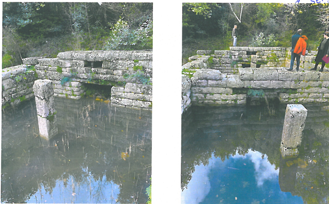
Fig. 15 Pamje e arkitrarëve të betonit dhe mureve të rindërtuar sipër tyre.
